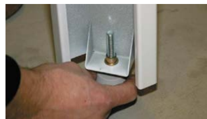
3. Justera fötterna så att stativet står i våg. Nu är stativet klart för inmontering av badkar.
